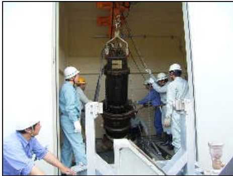
①与越川 消流雪兼用ポンプ取外し
