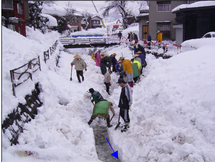
導入前の与越川の状況 (平成17年1月撮影)
