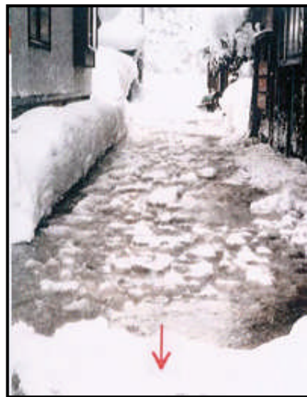
旧与越川の流量が少ないため投入した雪が堆積して家屋が浸水している状況 (平成13年1月撮影)
