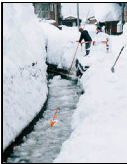
雪により旧与越川の流れが悪くなっている状況 雪を棒で突いて流している (平成13年1月撮影)
