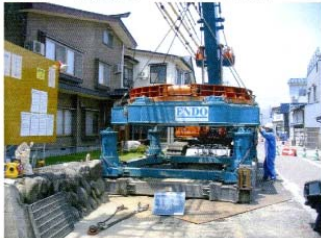
③立坑（鋼製ケーシング立坑）
