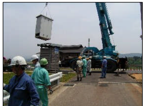
④湯殿川 機側操作盤取付
