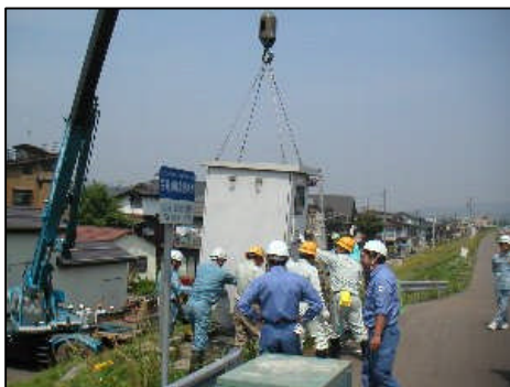
②与越川 機側操作盤取り外し
