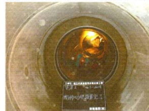
④導水路（長距離急曲線推進工法）
