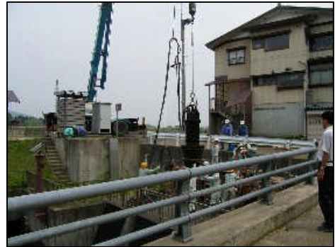
③湯殿川 ポンプ取付
